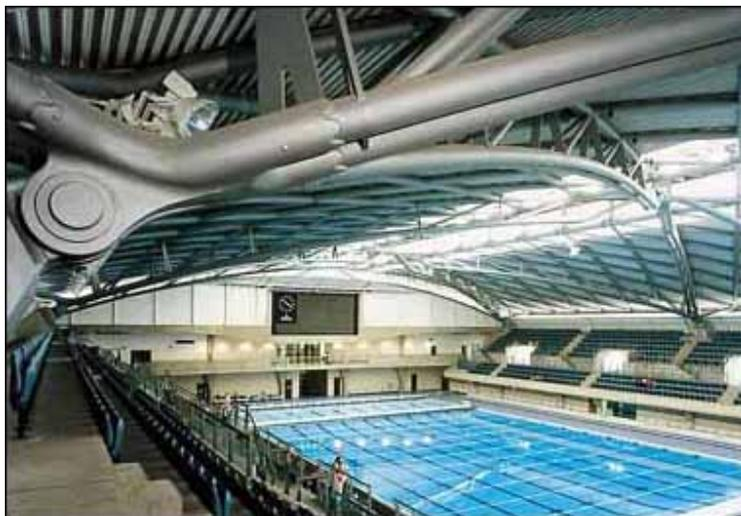
Il tetto a tutto sesto, che si estende a coprire un'area di 90 m x 50 m, è formato da una serie di archi diagonali interconnessi, di costruzione tubolare.
